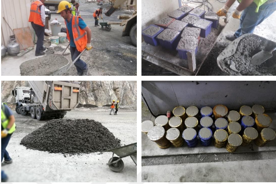
Şekil 21. Taze betondan numune alma
