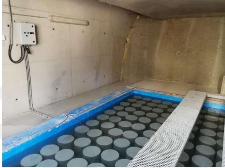
Şekil 11. Betonların bekletildiği kür havuzu
