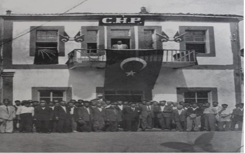
Resim 2. Rize CHP Binası.
