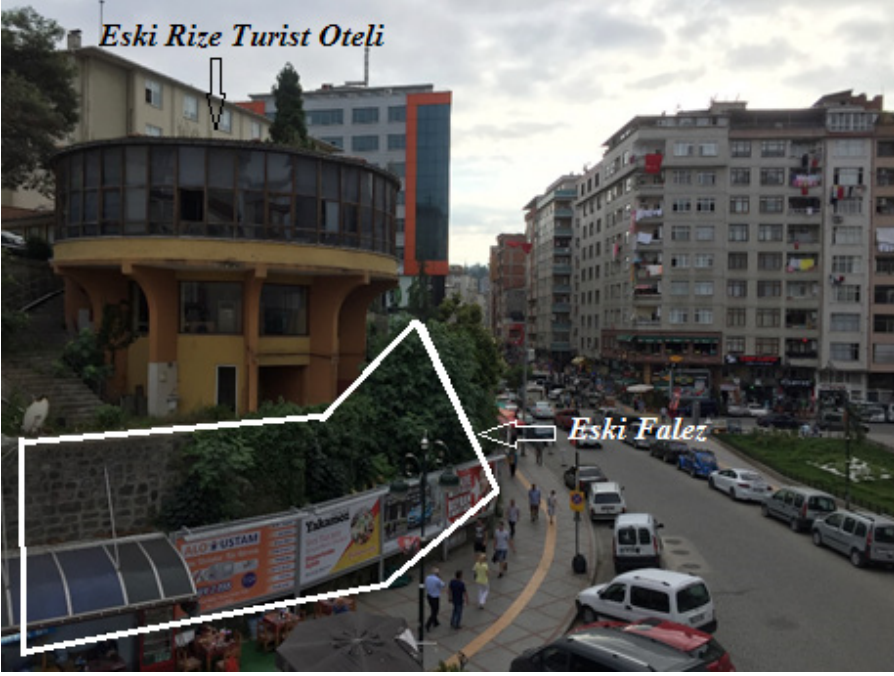
Foto 4. Günümüzde Ticaret ve Sanayi Odası olan Eski Rize Turist Oteli'nin üzerinde bulunduğu falezler yol kenarındaki istinat duvarı ile kapatılmış durumdadır.
