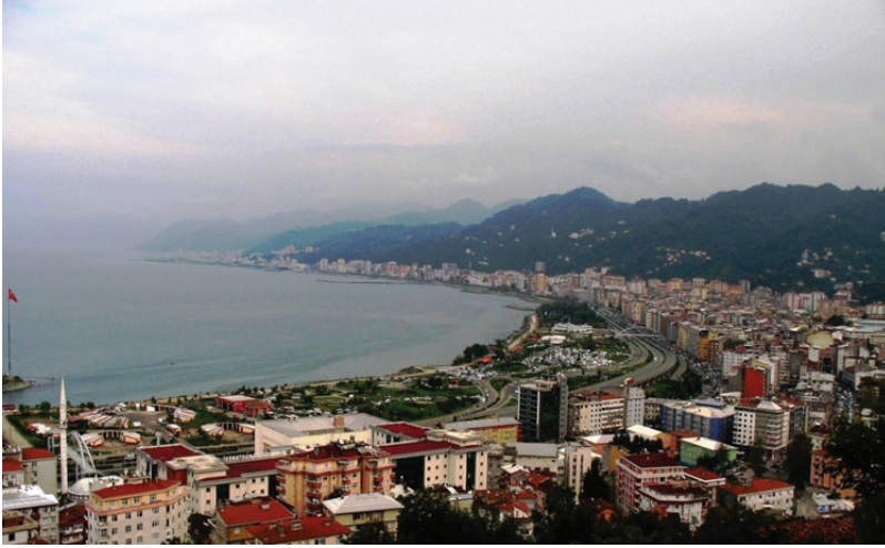
Foto 8. Rize şehri kıyısında yoğun yerleşme alanlarından ticarî ve kurumsal faaliyetlerin de yapıldığı Fener, Ekrem Orhon ve Eminettin mahallelerinin Rize Kalesi'nden görünümü
