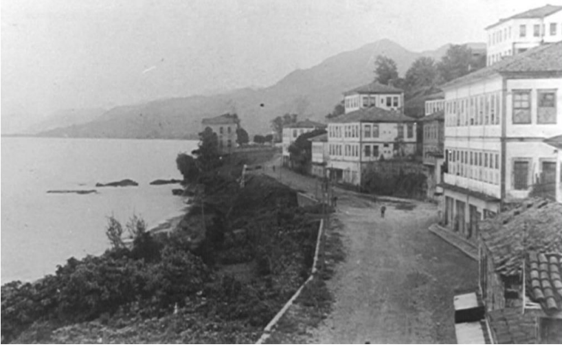
Foto 12. 1950 öncesi Rize şehri kıyısındaki sahil yolu ve hemen gerisinde falezler üzerine inşa edilmiş geleneksel konutlar. Günümüzde bu konutlar kıyının doldurulması ile birlikte kıyı gerisinde mahalle içlerinde kalmış durumdadır.
