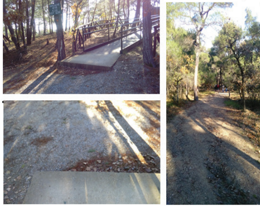
Şekil 8.Engelli Rampa Sorunu (Tachir,2016
