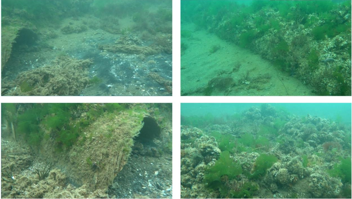
Şekil 5. 1999 yılında yaşanan Gölcük depreminde kırılmış olan Yalova eski derin deniz deşarjı çıkış noktası
